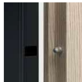
tŕne proti vysadeniu
